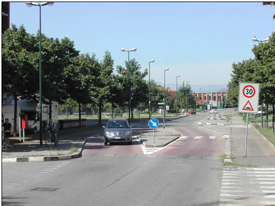
Figura 3.8 – Esempio di Zona 30 realizzata in Torino (Via Pietro Cossa)
