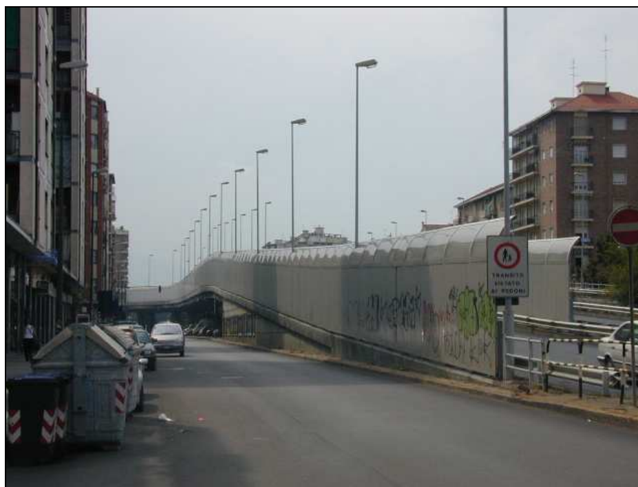
Figura 3.12 – Esempio di barriera acustica a Torino (Corso Grosseto)
