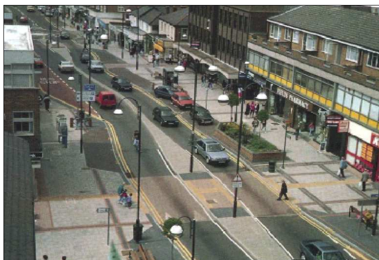
Figura 3.10 – Esempio di deflessioni orizzontali (chicane) e verticali (dossi) all'interno di una Zona 30
