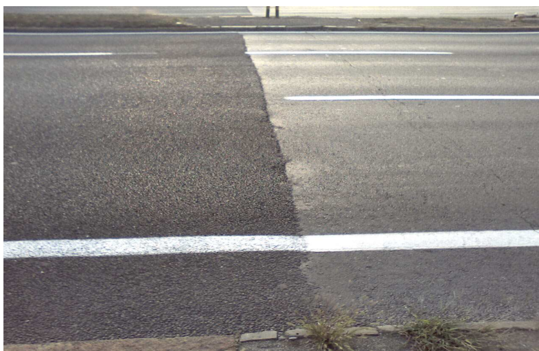
Figura 3.11 – Corso Vercelli, asfalto semigrenù (a sinistra) e tradizionale
