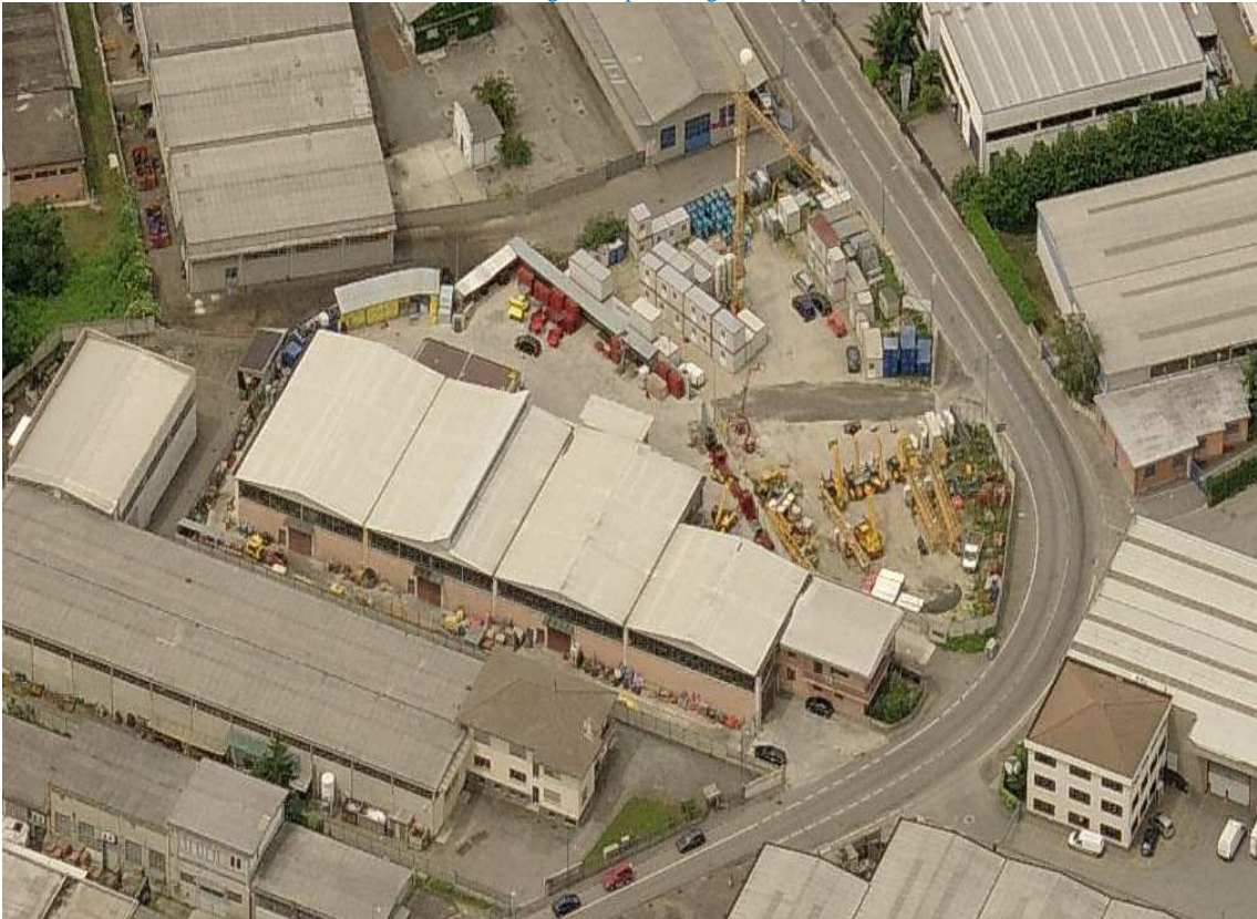
Vista aerea imm.le in Strada del Francese 92
