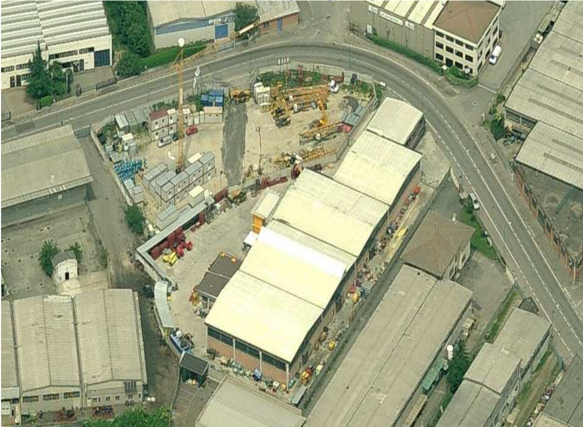
Vista aerea imm.le in Strada del Francese 92
