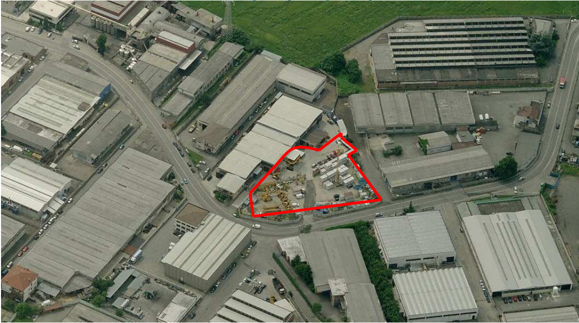
Vista aerea imm.le in Strada del Francese 92
