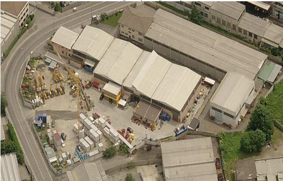
Vista aerea imm.le in Strada del Francese 92
