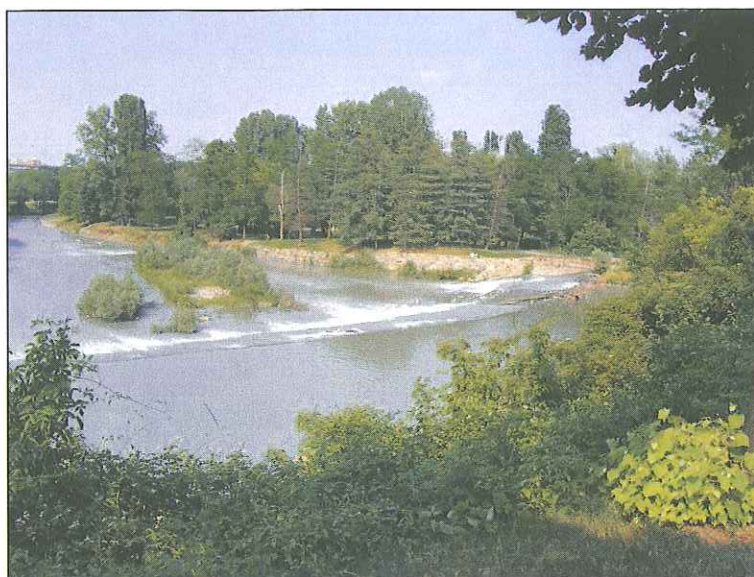
Figura 2 - Traversa fluviale della Dora Riparia in corrispondenza dell'opera di presa del canale Pellerina.
