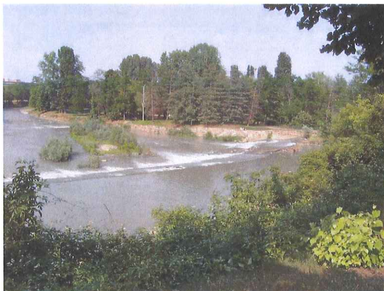
Foto 1 – Traversa fluviale della Dora Riparia in corrispondenza dell’opera di presa del canale Pellerina.
