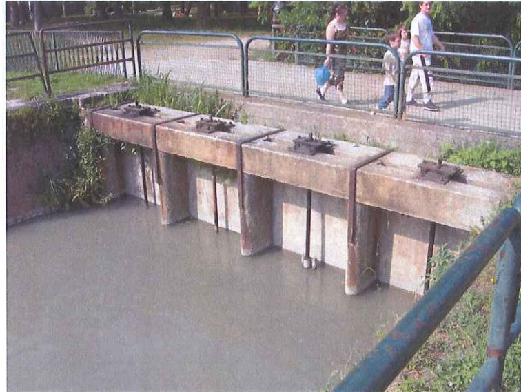
Foto 5 – Paratoie di regolazione del canale dissabbiatore – sghiaiatore.
