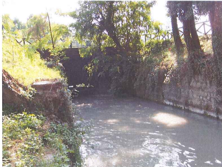
Foto 7 – Tratto iniziale del canale dissabbiatore – sghiaiatore visto da valle.
