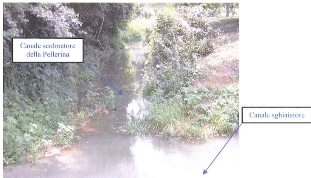
Foto 6 - Punto di confluenza fra il canale di restituzione in Dora della portata in eccesso del canale Pellerina (a sinistra) e il canale sghiaiatore (a destra).
