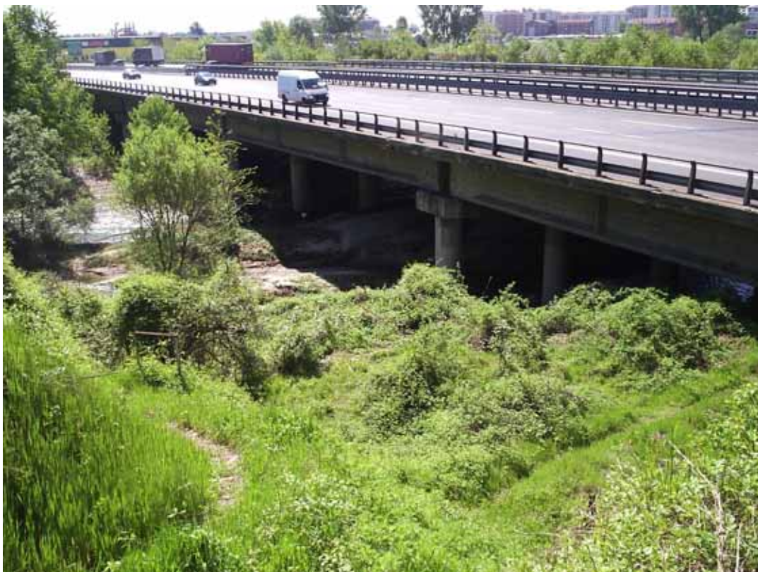
Foto 4 – Particolare zona di realizzazione pista di accesso
